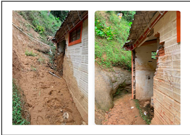
7. DAÑOS GENERADOS POR MOVIMIENTOS EN MASA — ESCUELA EL MORRO — REGIÓN DEL SUROESTE ANTIOQUEÑO — EVENTO REGISTRADO EN 2021.
