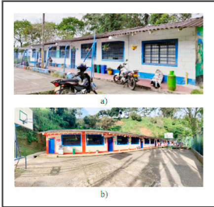
6. TIPOLOGÍAS ESTRUCTURALES MÁS REPRESENTATIVAS: A) MAMPOSTERÍA SIMPLE B) MAMPOSTERÍA SEMI CONFINADA
