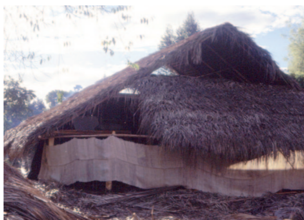
La maloca en proceso de construcción (1997)
